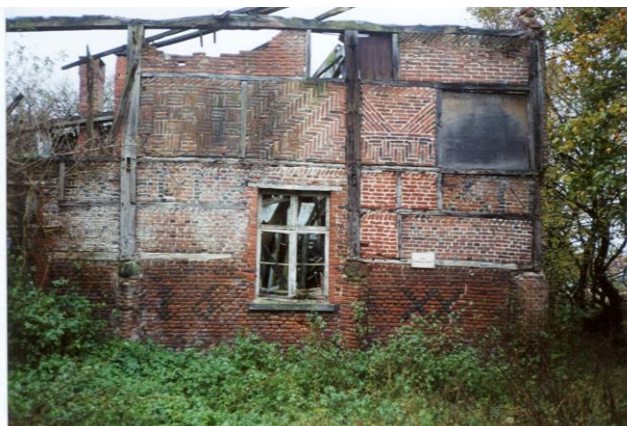
het pannenhuis Balen - 1620, vakwerk met baksteenvulling in motieven, ramen oorspronkelijk gekoppeld aan de standers
