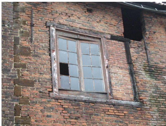
Zesvaks kozijnraam achtergevel, toestand 2011
