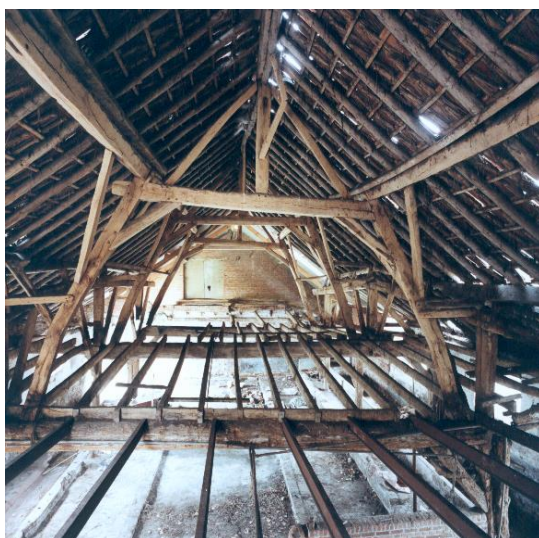
typisch 18 e eeuws gebint de dakbedekking met oude boomse pannen er is geen onderdak
