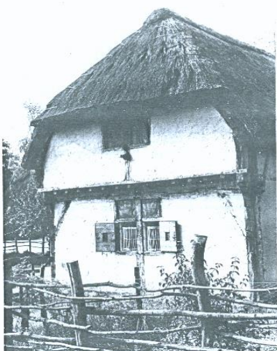
overkragende gevel kruisraam in het vakwerk
